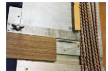
Segellast. Auf einem Rahmen wurden die Leisten aus Mahagoni geklebt. Die Kanten des Lukendeckels sind, wie auch bei der Schiebeluk des Niedergangs, mit einem HohlkehlfrĤser ausgefrĤst.
