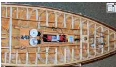
Bild 10: Umlaufschotgestell während der Einbauarbeiten
